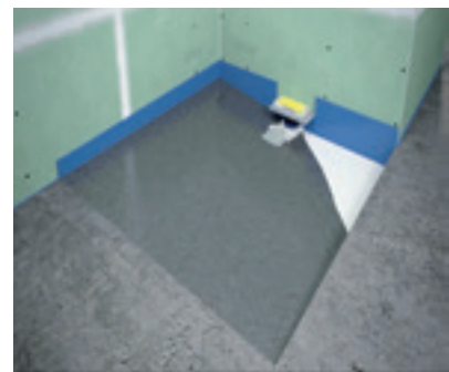
↑ STØB GULV MED DEN RETTE HÆLDNING
