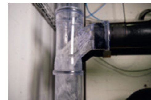
... og det identiske resultat er synligt under virkelige forhold i Geberit afløbstårnet, som er en del af testlaboratoriet.
